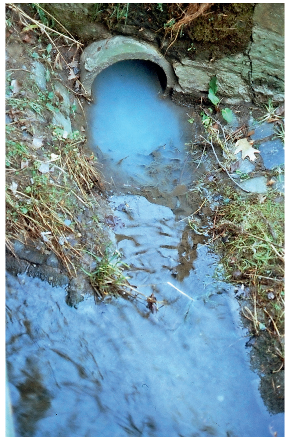
Abbildung 27: Einleitung von Abwasser unbekannter Herkunft in den Grunnelbach bei Trockenwetter. Kassel-Niederzwehren. Aufnahme von Jochen WULFHORST am 03.04.1999
