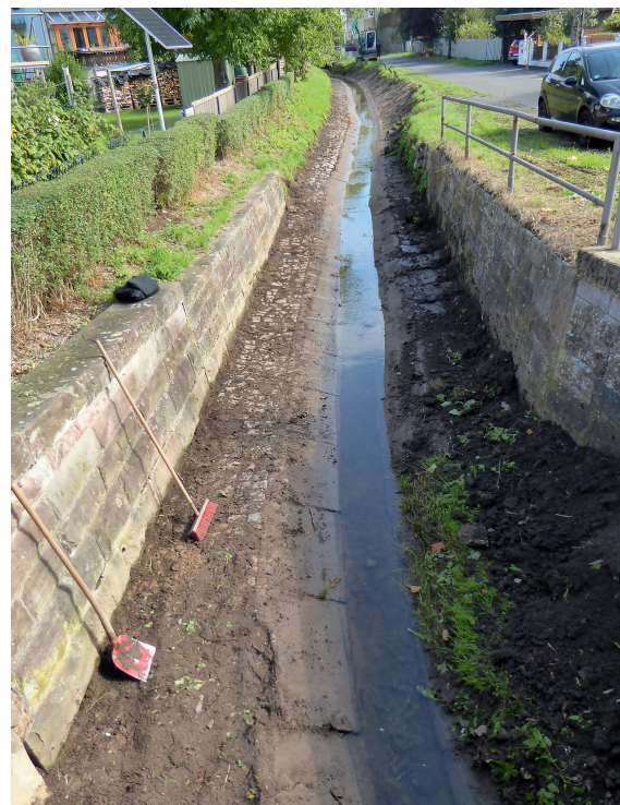
Abbildung 26: Entfernung der nährstoffreichen Sedimentauflage mit Blutweiderich auf dem Uferpflaster des Heisebachs in Kassel-Oberzwehren; Entleerung des Baggerguts in die fließende Welle. Bagger im Hintergrund.
